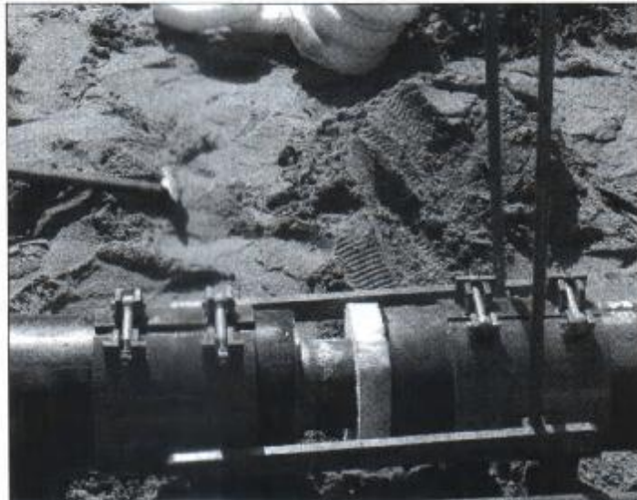
Рисунок 5 – Сборка соединения «ВРС» предварительно изолированных труб из ВЧШГ с использованием приспособления рычажного типа
