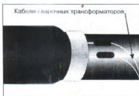
Рисунок В.7 – Присоединение сварочных трансформаторов
