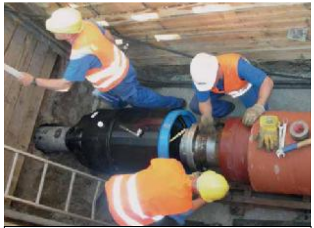
Рис. 9 Соединение римера с новой трубой
