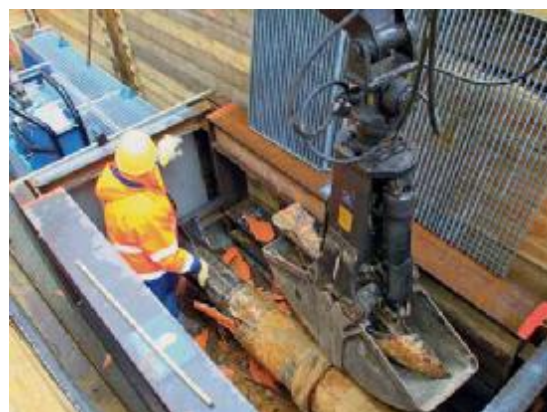
Рис.11 Уничтожение старого трубопровода и трубы ПВХ
