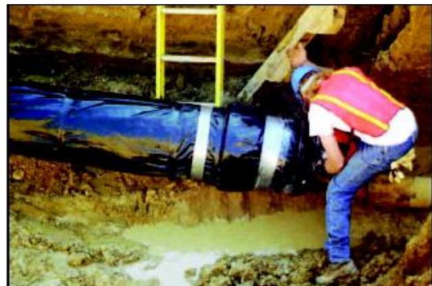
Рисунок 6.22 Покрытие труб полиэтиленовым рукавом.
