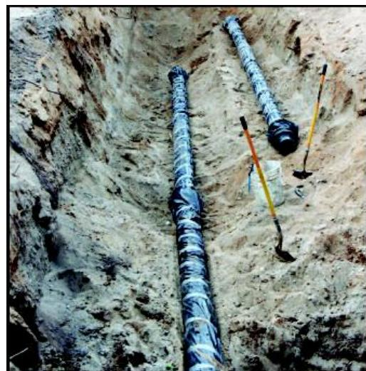
Рисунок 6.24 Картриджный метод укладки труб.
