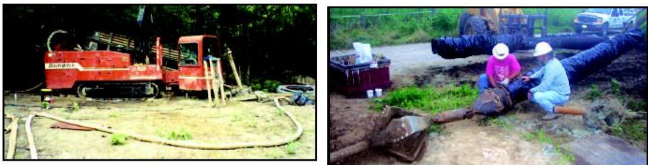
Рисунок 6.17 Прокладка трубопровода методом горизонтально направленного бурения.
