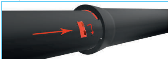
6. Стыковка труб и установка стопоров
