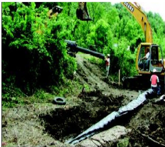
Рисунок 6.24 Картриджный метод укладки труб.
