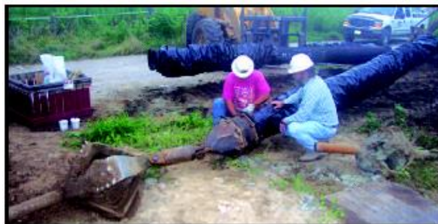
Рисунок 6.17 Прокладка трубопровода методом горизонтально направленного бурения.
