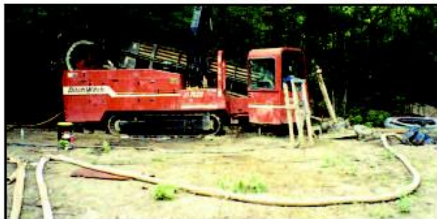
Рисунок 6.17 Прокладка трубопровода методом горизонтально направленного бурения.
