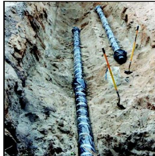
Рисунок 6.24 Картриджный метод укладки труб.
