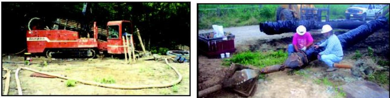
Рисунок 6.17 Прокладка трубопровода методом горизонтально направленного бурения.
