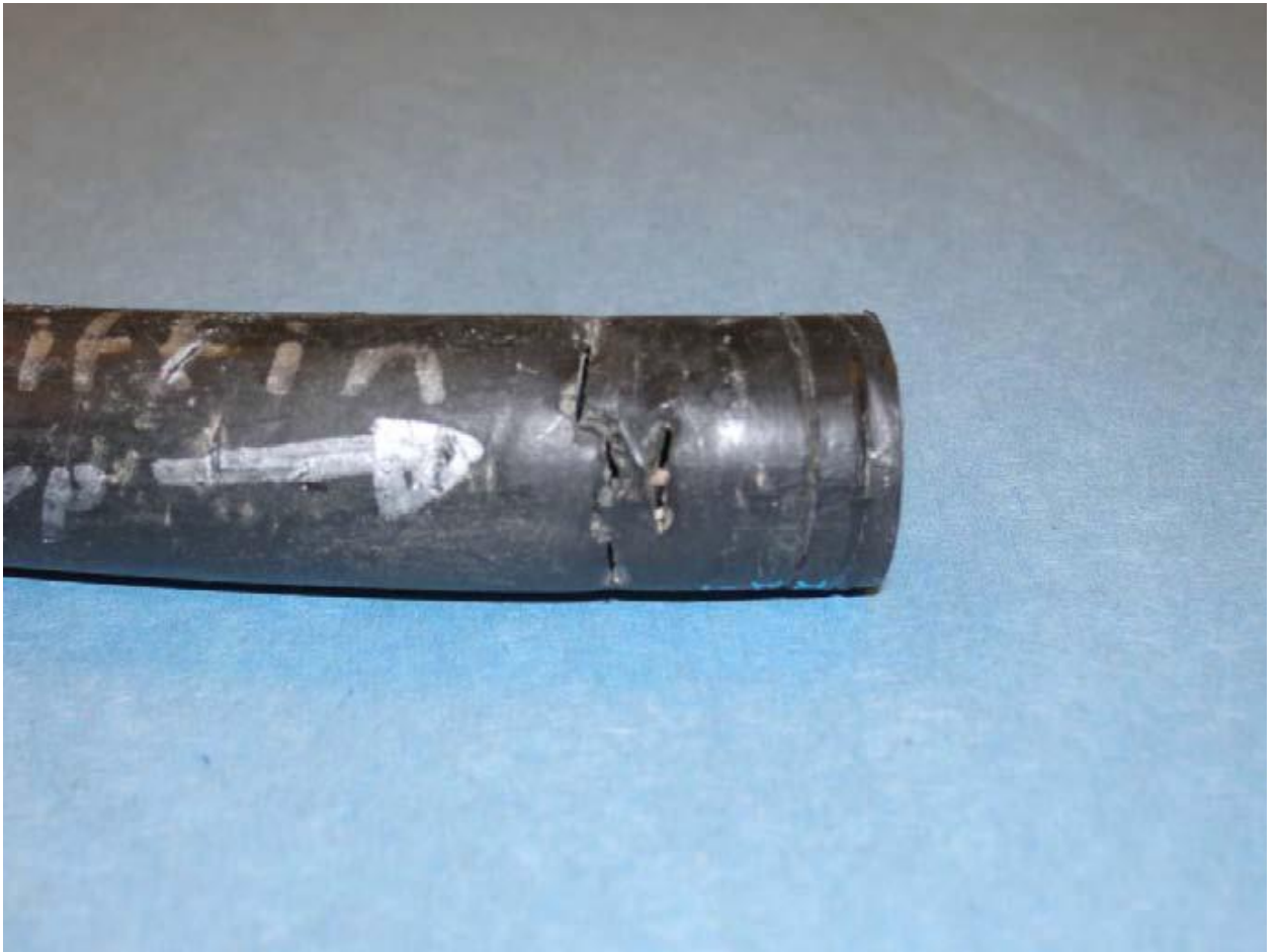
Снимок 36. Повреждение фасонной части. Гамильтон, Огайо.
