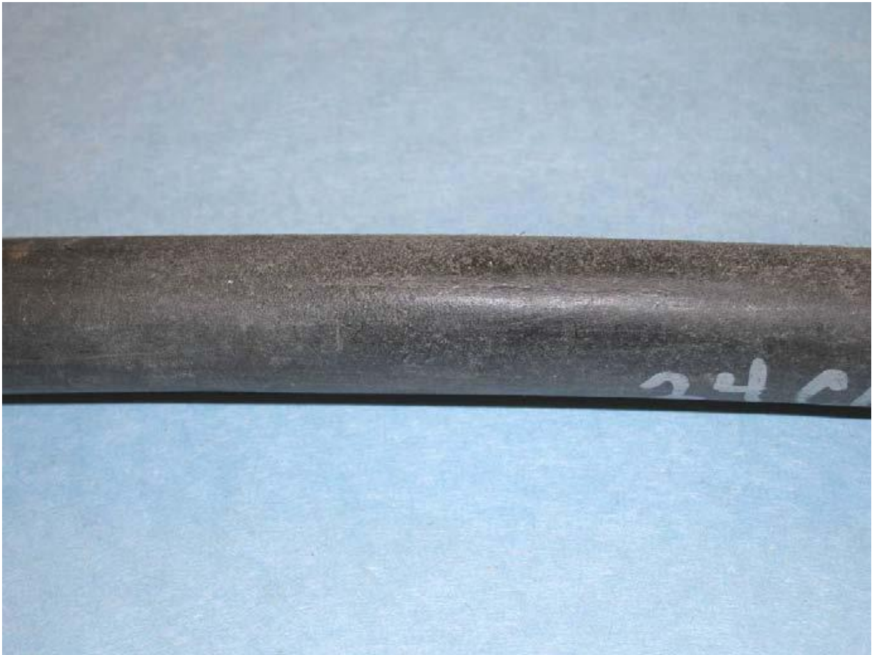
Снимок 31. Образец с продольной трещиной. Гамильтон, Огайо.
