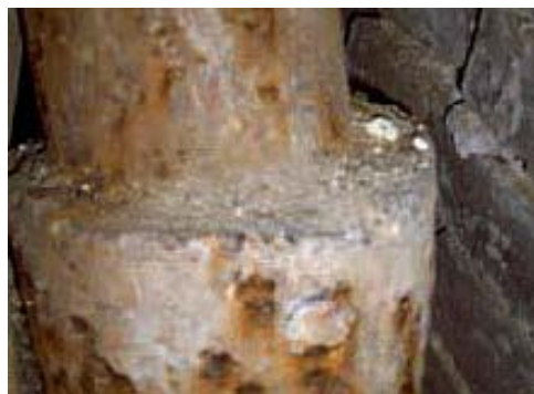
Рис.2 раструбное заединение трубы в замке в Касселе
