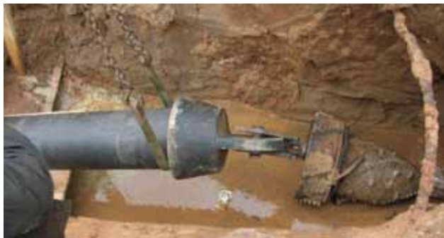
Рис. 9. Прокладка трубопровода в г. Иваново диаметром 150 мм и диаметром 300 мм
