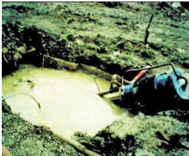
Рис. 3. Входное отверстие для ГНБ и циркуляционный насос для бурового раствора
