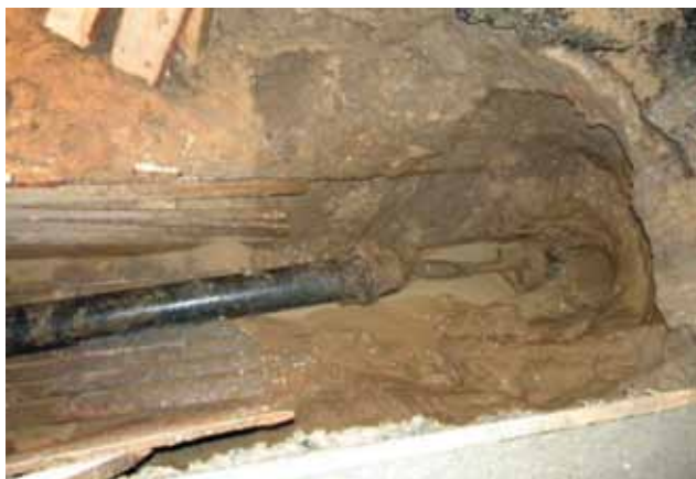
Рис. 13. Прокладка дюкера диаметром 200 мм из ВЧШГ под рекой Амур (г. Хабаровск)
