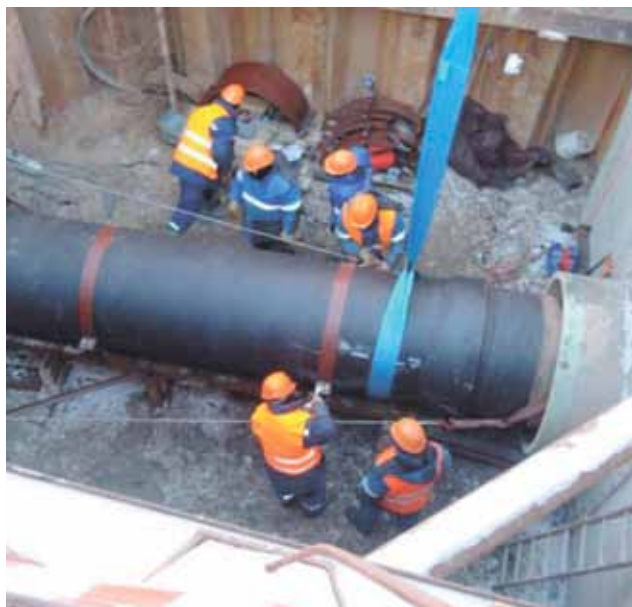
Рис. 16. Замена трубы методом продавливания диаметром 300 мм на диаметр 500 мм ВЧШГ в г. Берлине
