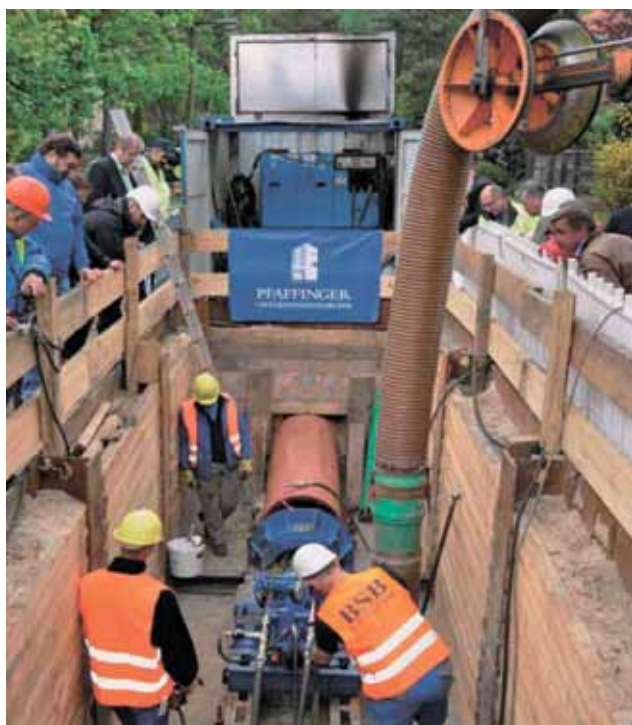
Рис. 16. Замена трубы методом продавливания диаметром 300 мм на диаметр 500 мм ВЧШГ в г. Берлине
