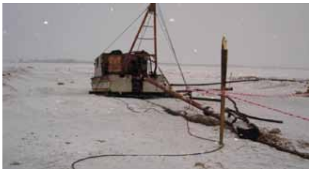
Рис. 14. Пример прокладки методом «труба в трубе» диаметром 400 мм
