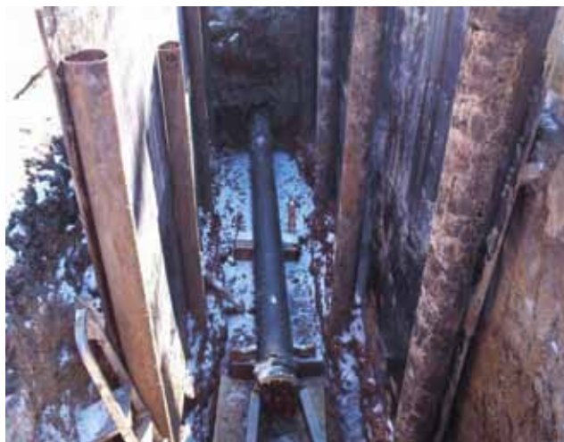
Рис. 10. Прокладка водовода в г. Москва (Новые Черемушки)
