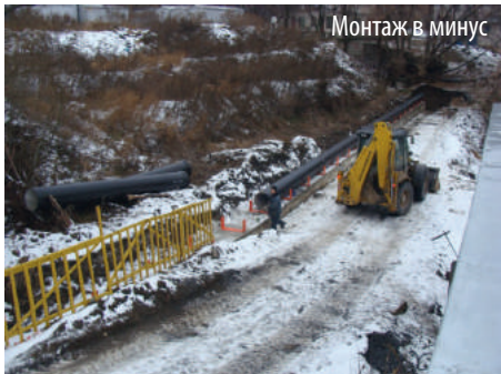
Монтаж с обратной засыпкой вынутым грунтом
