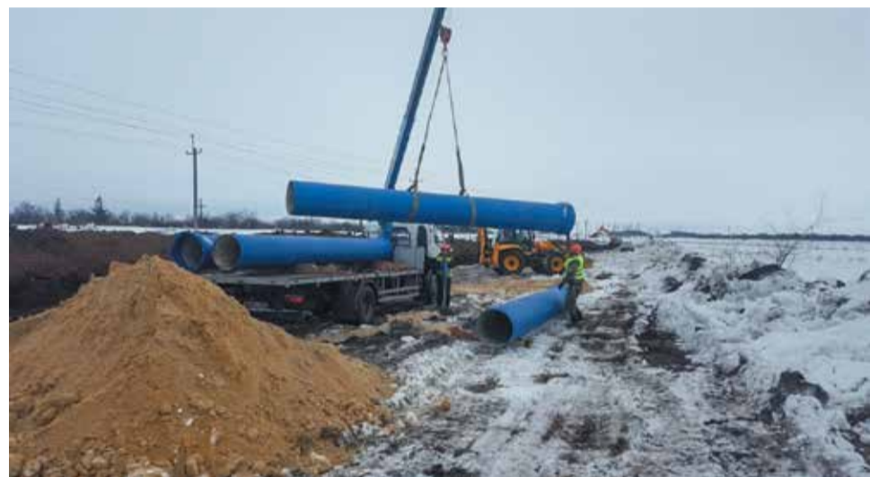
Разгрузка труб из ВЧШГ на строительную площадку
