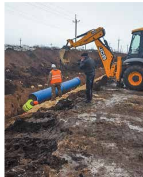
Укладка трубы из ВЧШГ в подготовленную траншею
