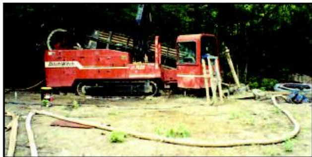
Рисунок 6.17 Прокладка трубопровода методом горизонтально направленного бурения.
