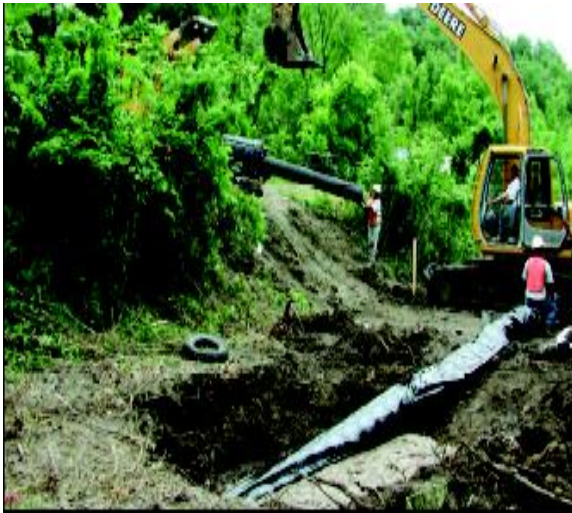
Рисунок 6.24 Картриджный метод укладки труб.
