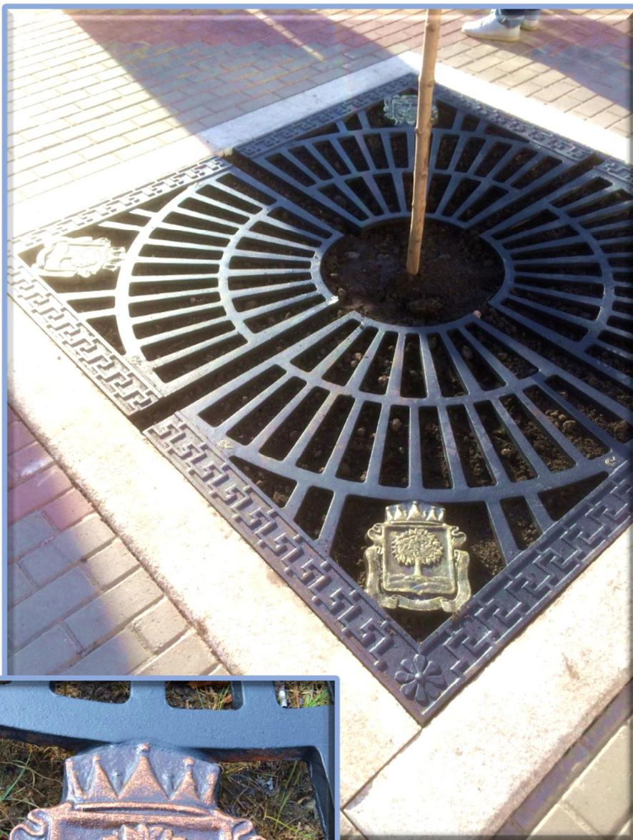
*Литая решётка приствольная из высокопрочного чугуна, состоящая из 4-х секций. Диаметр отверстия для ствола дерева – 500 мм.*
