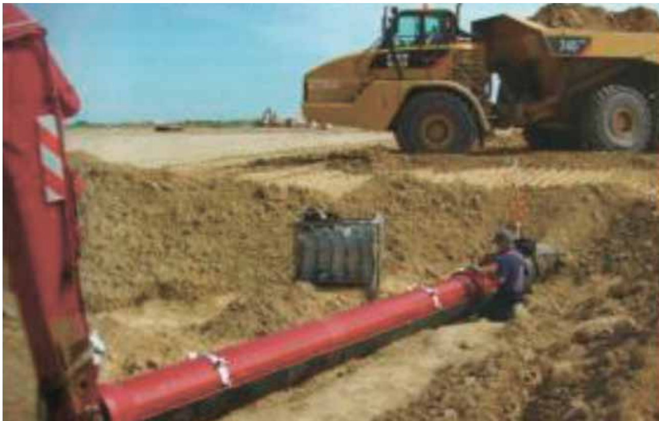
Рис. 14. Пример прокладки методом «труба в трубе» диаметром 400 мм
