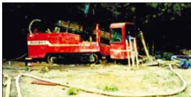
Рис. 1. Расширение размера скважин
