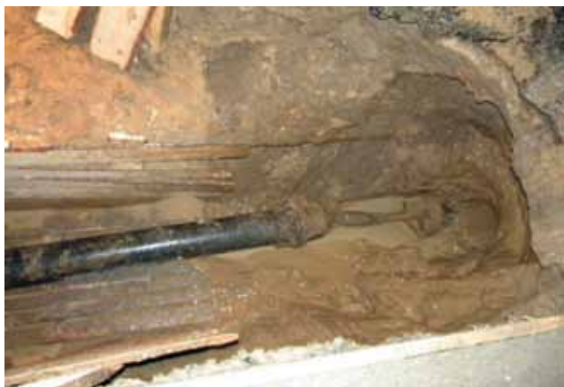
Рис. 13. Прокладка дюкера диаметром 200 мм из ВЧШГ под рекой Амур (г. Хабаровск)
