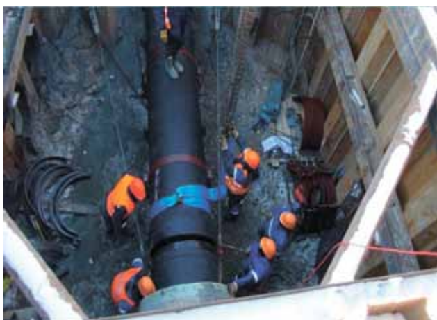
Рис. 8. Прокладка трубопровода в г. Санкт-Петербург диаметром 300 мм
