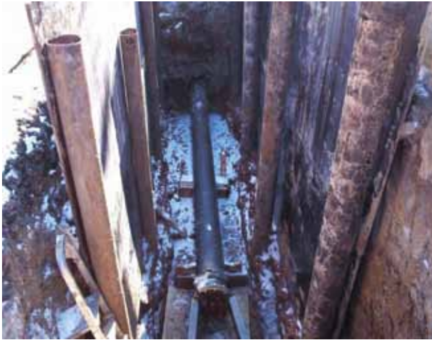
Рис. 10. Прокладка водовода в г. Москва (Новые Черемушки)
