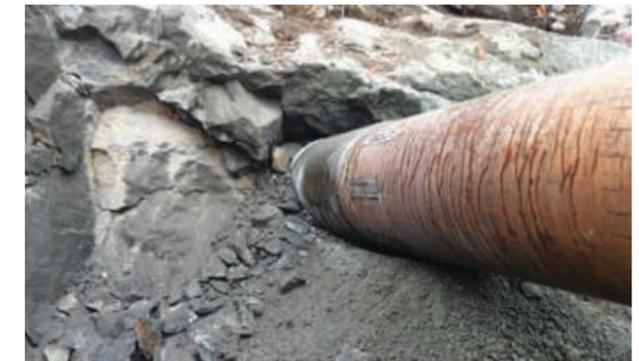
их последующим расширением с диаметра 165 мм до 650 мм. Этот случай показывает, что технология DTH бурения может хорошо адаптироваться к различным ситуациям. Результат бурения и прокладки трубопровода был успешным с конечным отклонением от цели менее одного метра по высоте (рис. 7). Скорость бурения с продвижением обсадной трубы диаметром 610 мм составила 3 м/ч.
