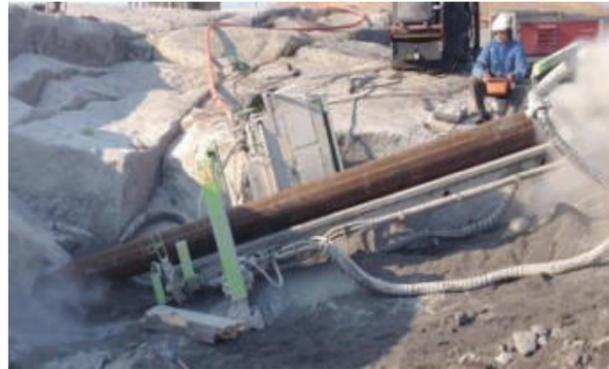
Самая большая установка HZR 810 представляет собой мощную машину для бестраншейной прокладки труб большого диаметра. Длина участка может составлять 6 м или 12 м. С помощью этого оборудования можно пробурить отверстия диаметром до 1220 мм (рис. 3).
