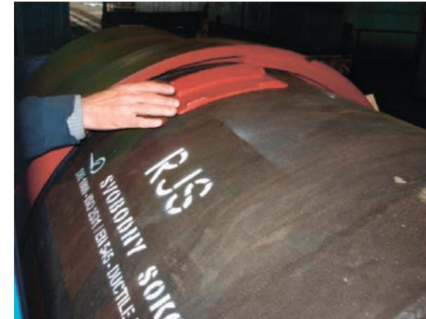
После сборки замкового соединения, стопоры через «ниши» в раструбе закладываются во внутреннюю камеру раструба и поочередно распределяются по окружности раструба вправо и влево.
