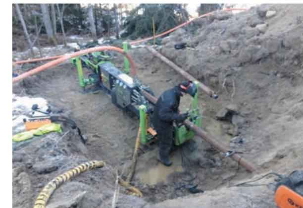
Буровые установки из среднего диапазона HZR 400 (рис. 2) и HZR 610 достаточно масштабные, но сохраняют мобильность перемещения и маневренность, несмотря на вес одной установки около 6150 кг. Они легко поднимаются с помощью мобильного крана или экскаватора. HZR 400 используется для бурения с применением обсадных труб диаметром до 406 мм и HZR 610 до 610 мм. Длины пробуренных скважин 3, 6 или 12 м.
