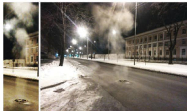
Рис. 2. Неорганизованный выброс газов под большим давлением привел к поднятию железобетонной крышки грузового проема шахты (г. Санкт-Петербург)
