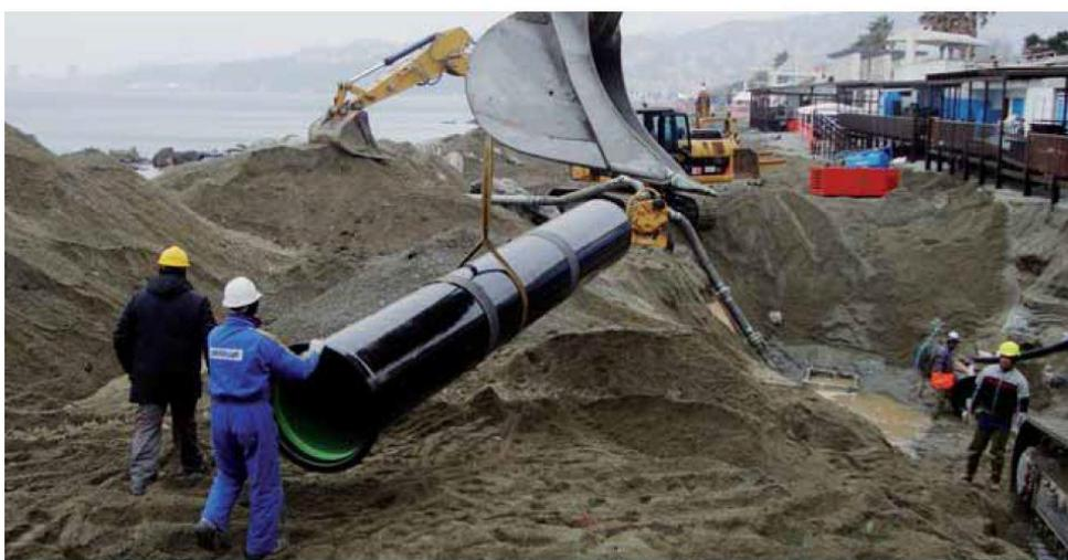
Новый трубопровод должен был отвечать некоторым требованиям: работа под давлением, стойкость к морской воде, гарантированная герметизация стыков, легкая сборка и хорошее соотношение цена-срок службы. Компания остановила свой выбор на трубе диаметром 700 мм из высокопрочного чугуна для монтажа на участке в 1050 метров с защитным полиуретановым покрытием ECOPEUR. Данное покрытие соответствует стандарту EN15189
