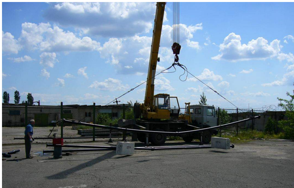
Рисунок 5 – Испытания плети с соединением “RJ” на внутреннее давление и изгиб.
